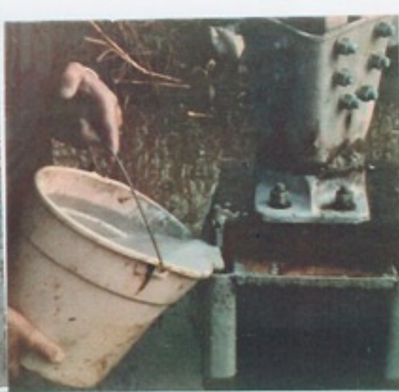
Initial pour of FX-70-6® Hydro-Ester Pourable Pack
